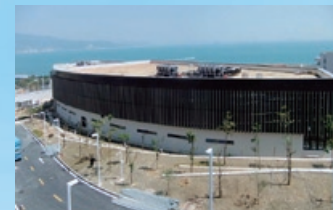
深圳水上体育館 (アスロックルーバー)
