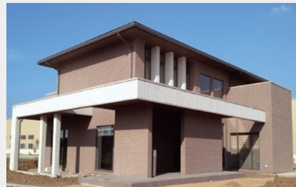
第1号物件 夢工場 住宅用軽量外壁材(シェルテックコンクリート)
