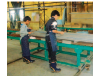
タイルパネルのタイル張り作業
