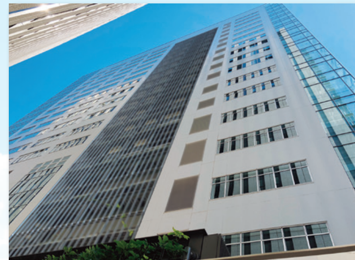
物件名：タワー・スコラ (日本大学理工学部駿河台校舎) (東京都千代田区)
