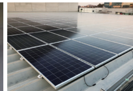
製造棟屋根に設置したソーラーパネル
