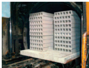
復旧したオートクレーブ設備
