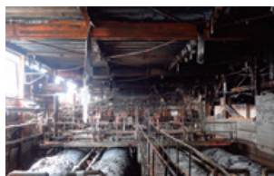
被災設備の状況(撮影:2019年5月14日)
