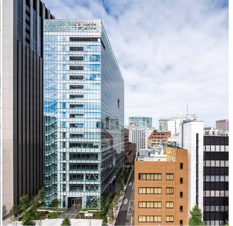
物件名 タワー・スコラ 外壁 「アルカス（二次防水仕様）」 所在地 東京都千代田区 工場塗装仕上げ（カラーフロン） 設計 梓設計 PHOTO エスエス東京 施工 清水建設
