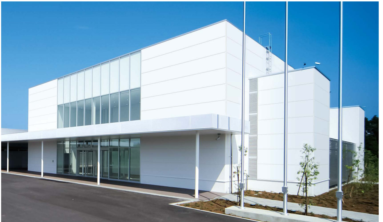
物件名 千代田テクノル大洗大貫台事業所 外壁 「アスロック900」 所在地 茨城県東茨城郡 現場塗装仕上げ 設計 KAJIMA DESIGN 施工 鹿島建設 関東支店
