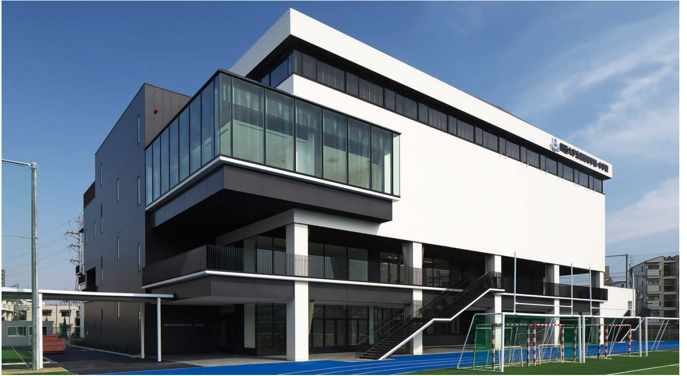
物件名 関西大学北陽高等学校・中学校 総合体育館 外壁 「アスロック600・900」 所在地 大阪市東淀川区 現場塗装仕上げ 設計 東畑建築事務所 施工 竹中工務店
