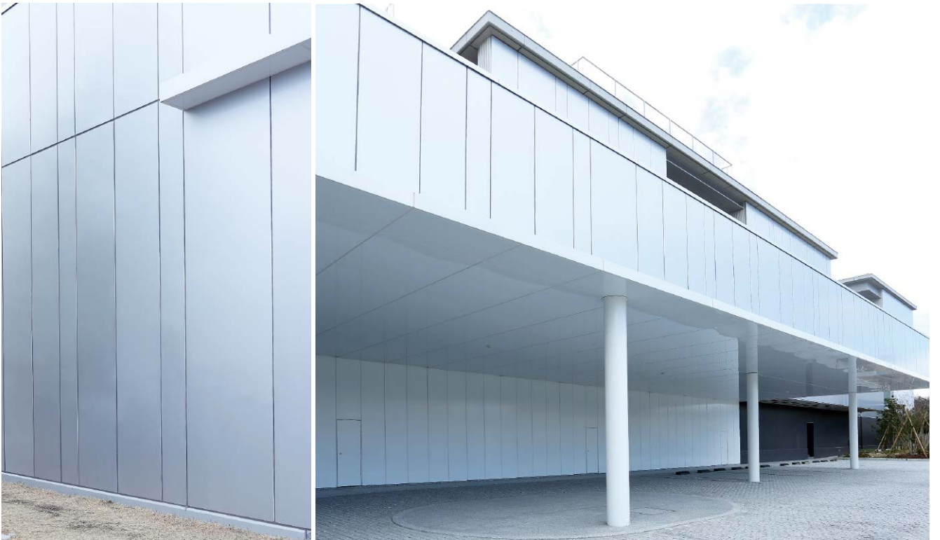
物件名 日東電工 茨木事業所 外壁 「アスロック600・900」 所在地 大阪府茨木市 工場塗装仕上げ(カラーフロンメタリック) 設計 日建設計 「ストライプライン600」 施工 大成建設 現場塗装仕上げ
