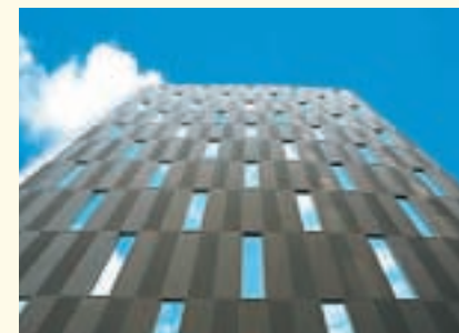
明治安田渡辺ビル (福岡県)
