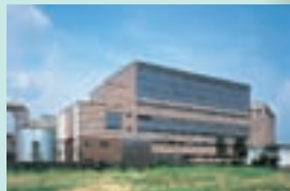
NEG大津工場厚生施設/1980 (アスロック60mm 現場塗装仕上げ)
