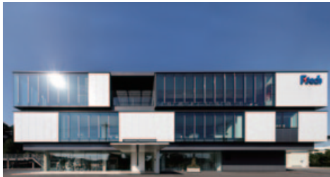
名称 / エフテック芳賀テクニカルセンター 品種 / アスロック900・プライムライン 工場塗装仕上げ (カラーフロン) PHOTO スタジオパワハウス
