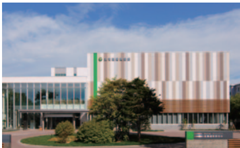
名称 / 公益社団法人 北海道看護協会 品種 / アスロック600・ストライプライン600・900・タスロック 工場塗装仕上げ (ニューカラリド)
