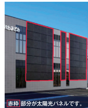
アスロックレールファスナー工法 (太陽光パネル仕上げ)
